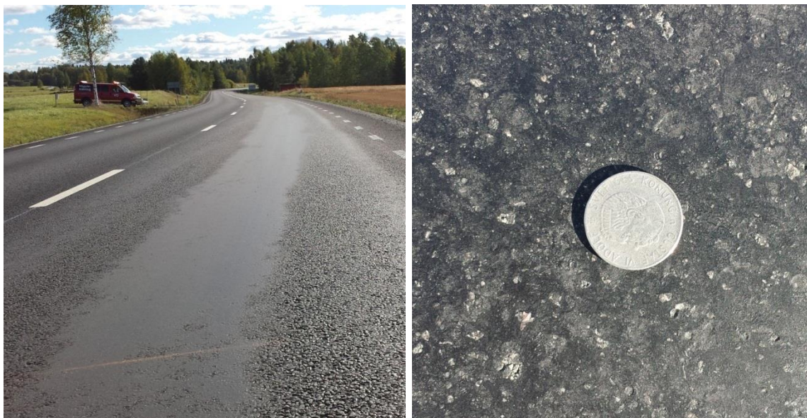
Figur 15. Blödning i samband med läggning (bild VTI).
