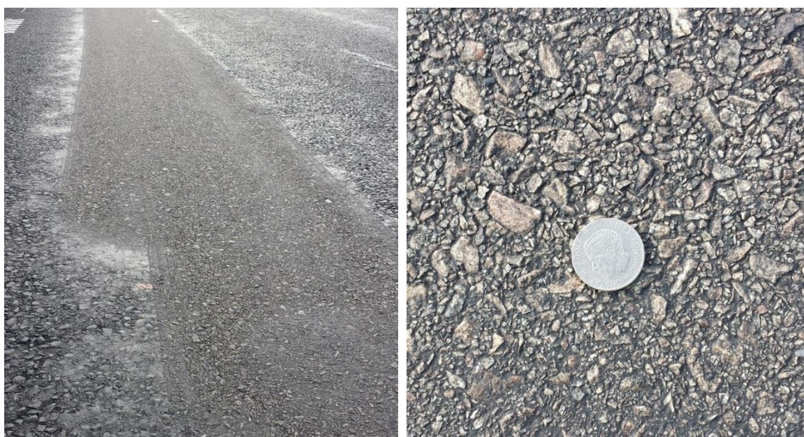
Figur 16. Blödande parti efter vattenblästring (bild VTI).
